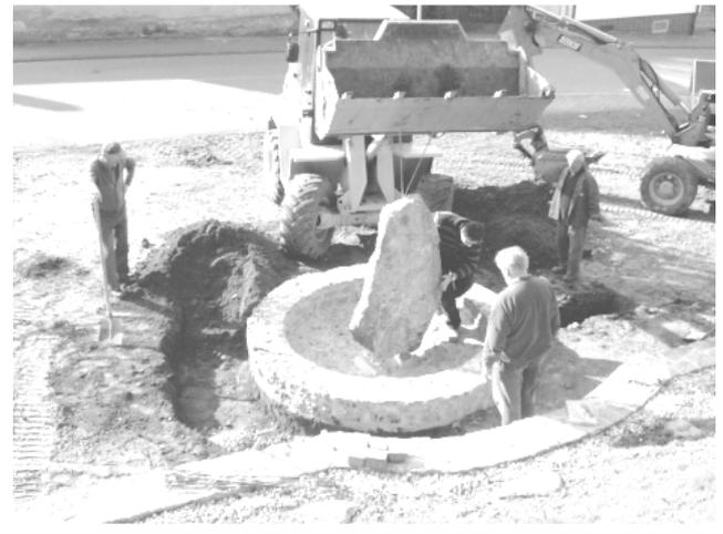
Bodendecker entfernt, Erdarbeiten durchgeführt, Bruchsteinmauer erbaut, Brunnenfassung gemauert, durchbohrter Findling gesetzt, Wege gepflastert, Zisterne gefertigt, Elektrik installiert, Mutterboden aufgetragen, Bänke montiert, Rasen gesät, Sträucher und Bäume gepflanzt, Rasen wächst: **Der Dorfplatz ist fertig!**
